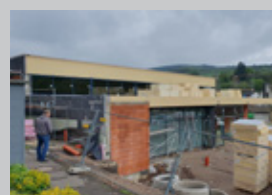
Die Baustelle in Gemünd
