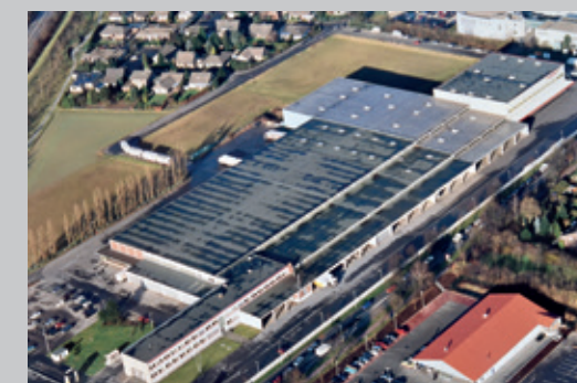
Ehemaliges REWE-Lager Erkelenz.
